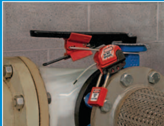
S3920 asegurado con el dispositivo de bloqueo de cable S806
